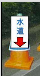
写真1 従前の埋設物の見える化方法
