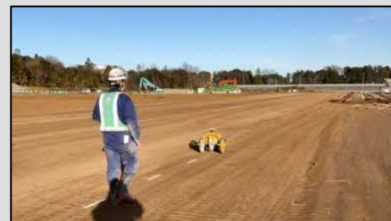
マーキング作業状況
